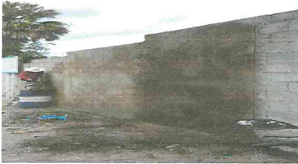
Foto1: Aplicación de repello y cernido a muro perimetral. TRABAJANDO
