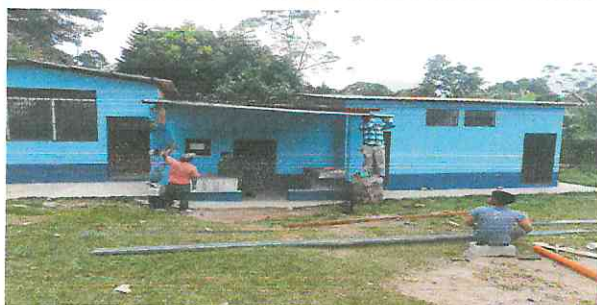
Foto 5: instalación de canales y bajadas pluviales (Bodega, cocina, y Baños). TRABAJANDO
