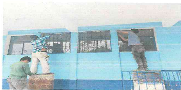
Foto 3: instalacion de balcones por seguridad. TRABAJANDO
