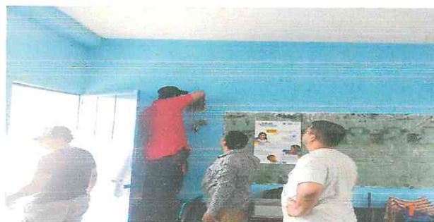
Foto 4: Instalación de caja de 6 filipones e instalacion de toma corrientes. TRABAJANDO
