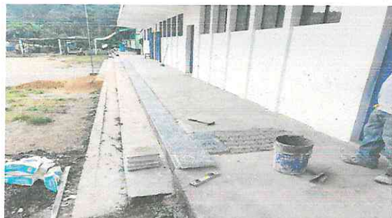
Foto1: Se sustituirá la torta de cemento por piso de granito en el corredor donde se encuentran las aulas por motivo de deterioro. TRABAJANDO
